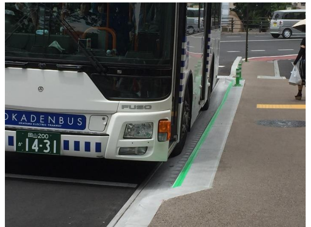
図 53 正着促進縁石の例（岡山県岡山市）
