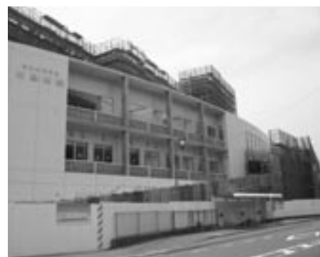
▲建設中の大島病院
