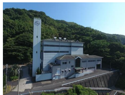
<周防大島町清掃センター>
