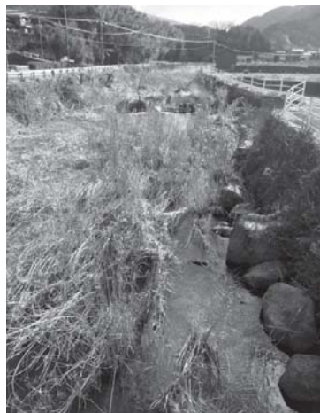
屋代川 吉井橋付近
