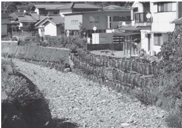
応急復旧された護岸（津久見市彦ノ内川）
