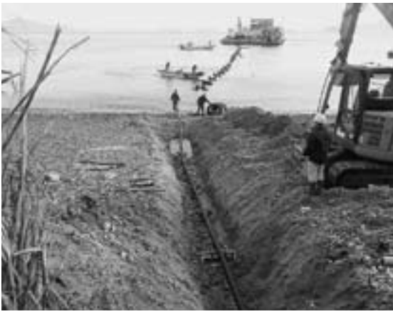
▲浮島側送水管布設工事（江ノ浦）
