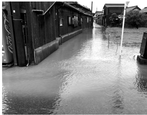
県道橋東和線船越地区 三叉路南側の冠水
