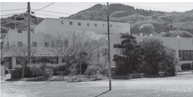
耐震改修された久賀公民館
