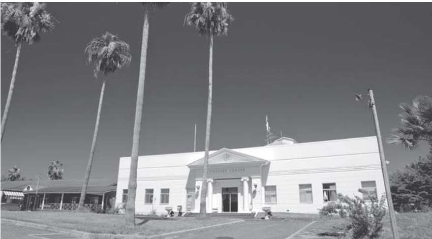
ながつらスポーツ滞在型施設
