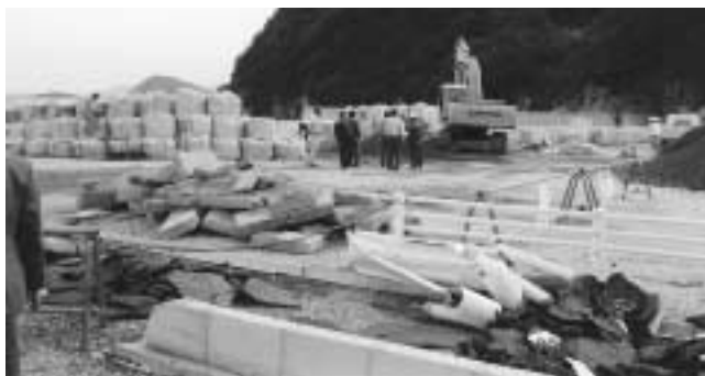
復旧現場(橋病院駐車場)
