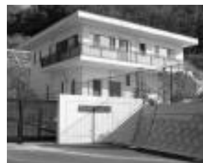
完成した沖浦東地区浄化センター
