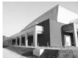
防災センター
