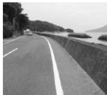
大島環状線（沖浦地区）
