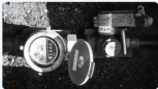
閉栓キャップによる給水停止
