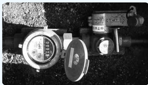
閉栓キャップによる給水停止
