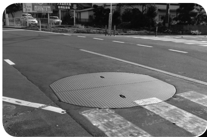
縦穴を覆っている「覆工板」④ と縦穴の中で行われている推進 工法の様子⑤
