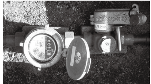
▲閉栓キャップによる給水停止
