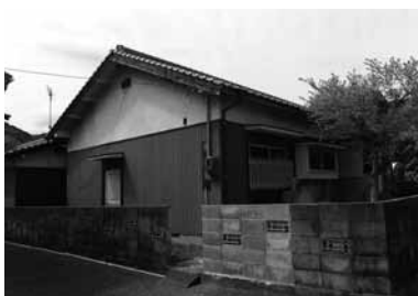
1. 久賀地区住宅
