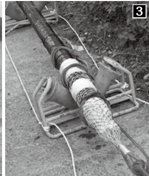
❶ 台船のターンテーブルから海へ送りだされる送水管 ❷ 送水管の陸揚げ作業の様子 ❸ 陸揚げされた送水管の先端
