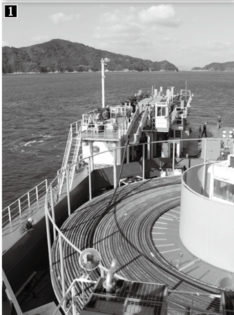
❶ 台船のターンテーブルから海へ送りだされる送水管 ❷ 送水管の陸揚げ作業の様子 ❸ 陸揚げされた送水管の先端
