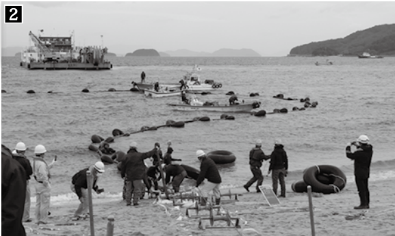
❶ 台船のターンテーブルから海へ送りだされる送水管 ❷ 送水管の陸揚げ作業の様子 ❸ 陸揚げされた送水管の先端
