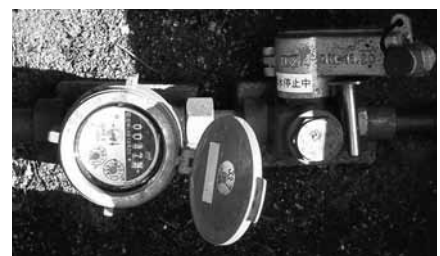
▲閉栓キャップによる給水停止
