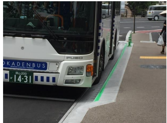
図 51 正着促進縁石の例（岡山県岡山市）
