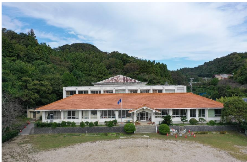
旧城山小学校
