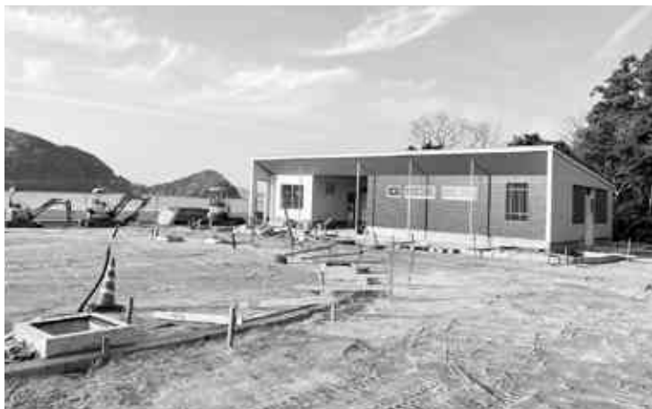
工事が進んでいる現地
