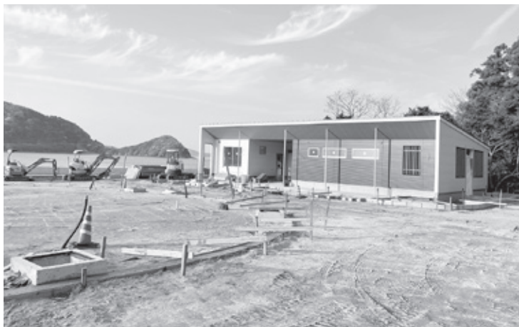
工事が進んでいる現地
