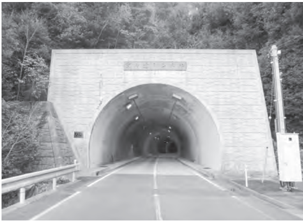
▲京ヶ迫トンネル (545 m)
