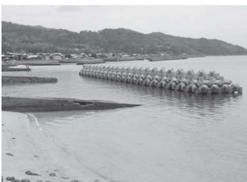
▲志佐漁港海岸保全施設 (平成29年度工事)
