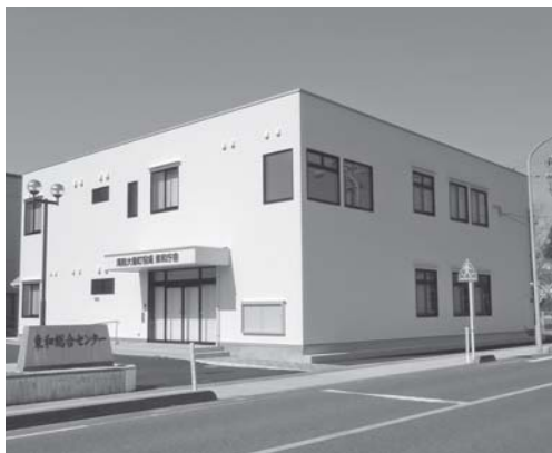
▲完成した東和庁舎
