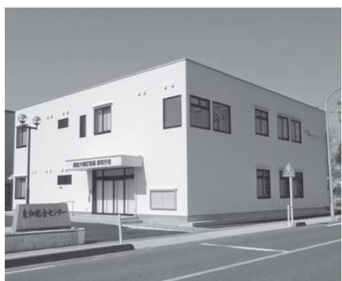
▲完成した東和庁舎
