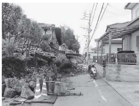
地震で倒壊した家屋
