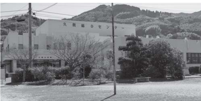
耐震改修された久賀公民館
