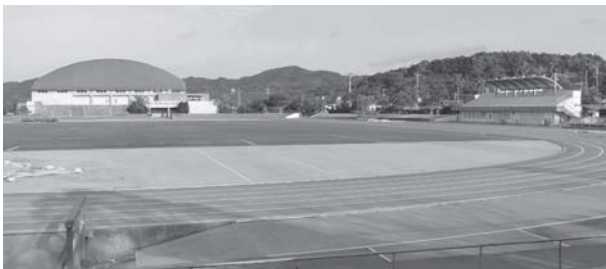
周防大島町陸上競技場
