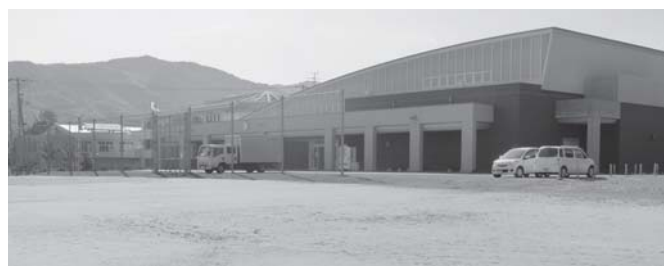
大島防災センター
