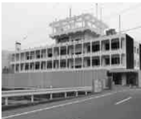
▲ 解体中の旧橋庁舎
