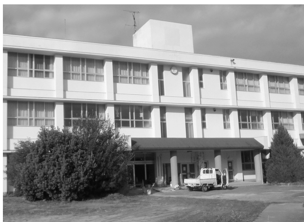
改修中の旧・日良居中学校
