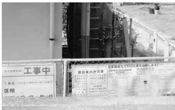
工事中の淡水化装置
