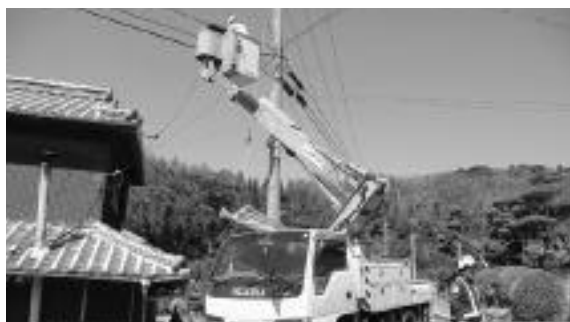
急ピッチで進められるCATV通信網
