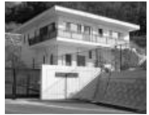
完成した沖浦東地区浄化センター
