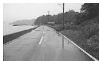
外灯のない県道
