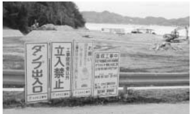
大泊最終処分工事現場
