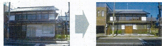
(例)地域活性化のため、空き家を観光交流施設へ改修
