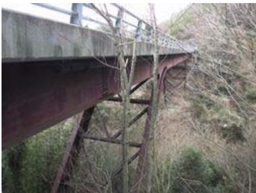
見山橋 橋梁形式：鋼橋 橋長：50.000m 架設年：1986 年
