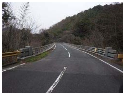
見山橋 橋梁形式：鋼橋 橋長：50.000m 架設年：1986 年
