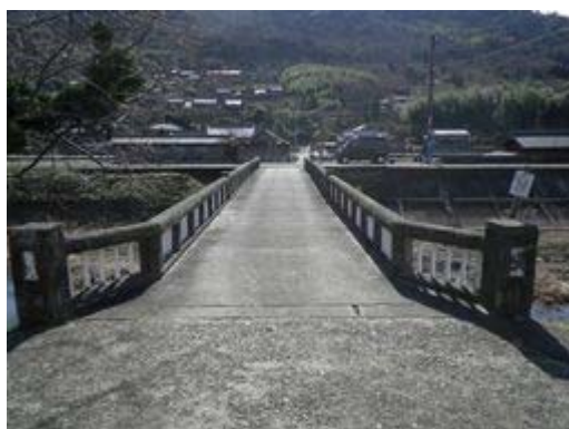
片山橋 橋梁形式：RC 橋 橋長：24.300m 架設年：1960 年
