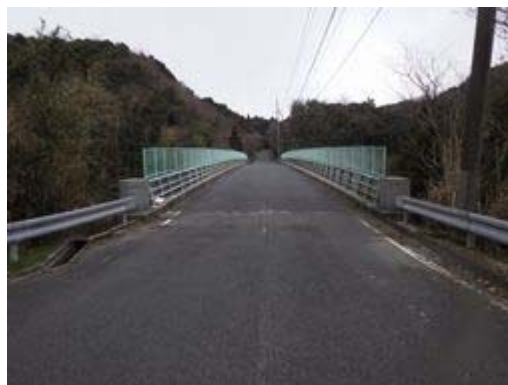
東和橋 橋梁形式：PC 橋 橋長：80.000m 架設年：1985 年
