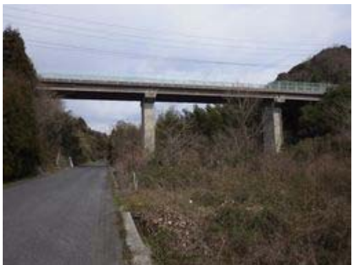
東和橋 橋梁形式：PC 橋 橋長：80.000m 架設年：1985 年
