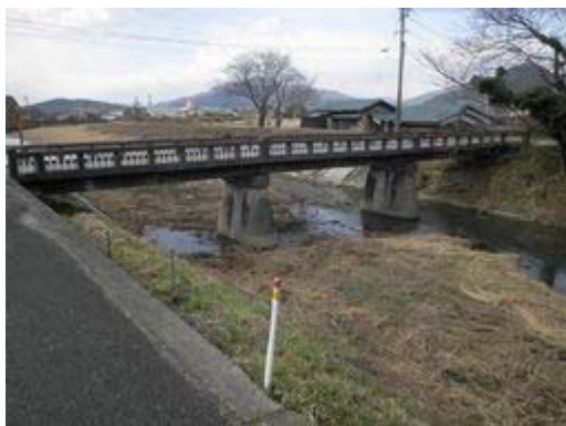
片山橋 橋梁形式：RC 橋 橋長：24.300m 架設年：1960 年
