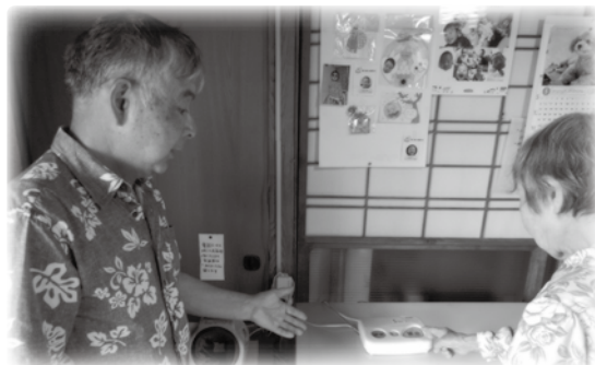
緊急通報装置設置の確認
