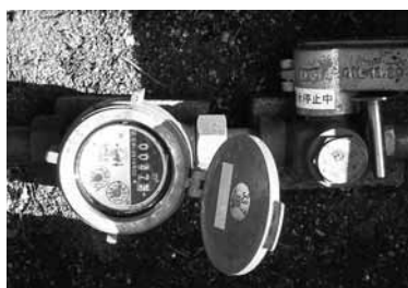
▲閉栓キャップによる給水停止
