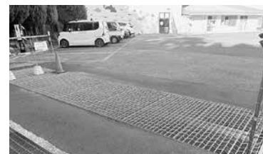
入口にイノシシ侵入防止グレーチングが設置され夜間キャンプも安心。
