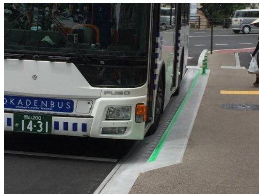
図 54 正着促進縁石の例（岡山県岡山市）
