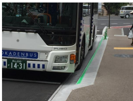
図 54 正着促進縁石の例（岡山県岡山市）
