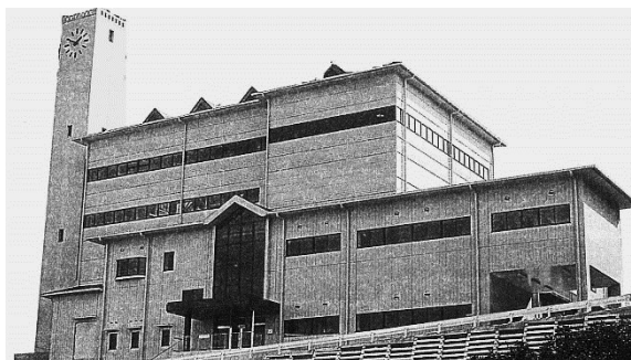
周防大島町清掃センター外観
