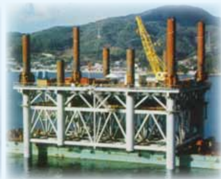
▲工事中の基礎
