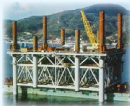
▲工事中の基礎
