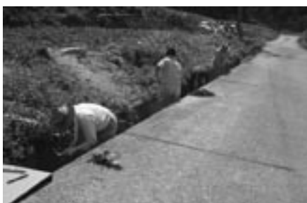
水路の泥上げ・補修
