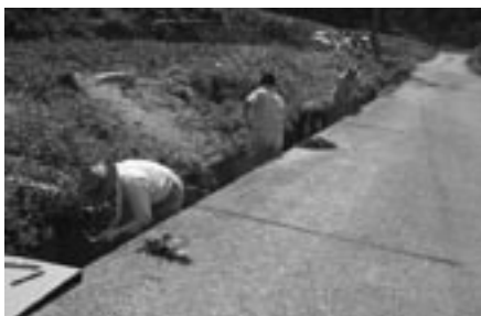
水路の泥上げ・補修
