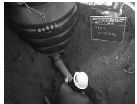
▲下水道工事の様子
